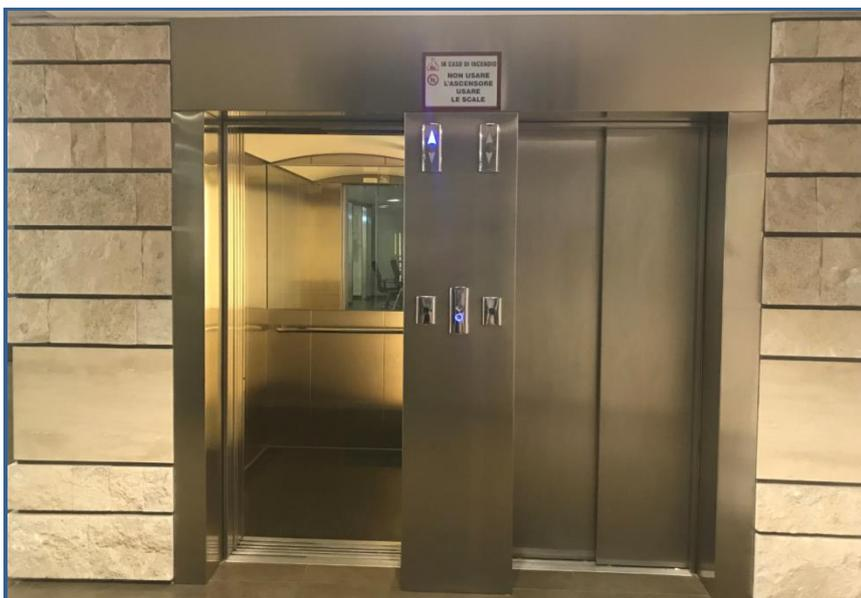
Particolare dello sbarco ascensori e rivestimento in acciaio inox e scorsa di travertino
